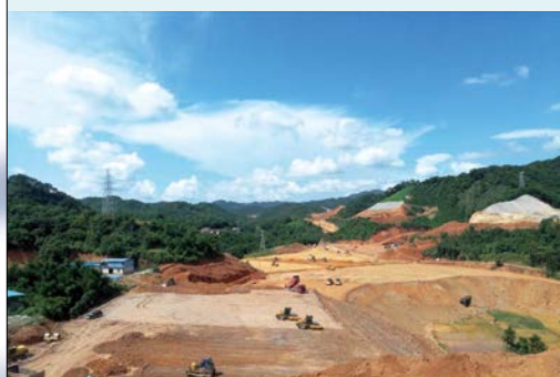
项目施工现场
